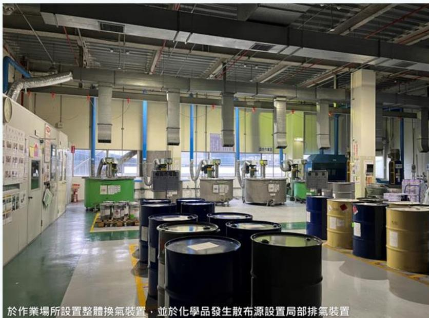
於作業場所設置整體換氣裝置，並於化學品發生散布源設置局部排氣裝置
