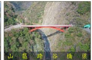
山區跨谷橋梁
