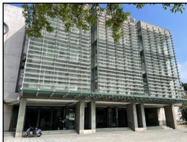
圖 3 建築整合型太陽光電設施
